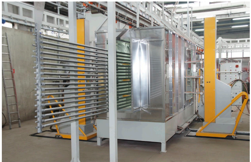
Widok na kabinę lakierniczą.
