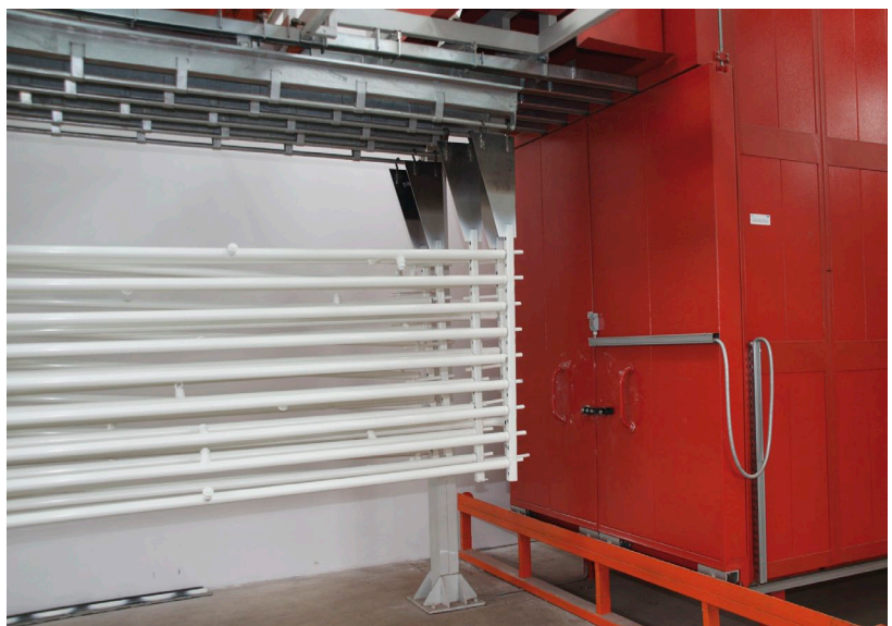
Elementy przed wejściem do pieca do polimeryzacji.
