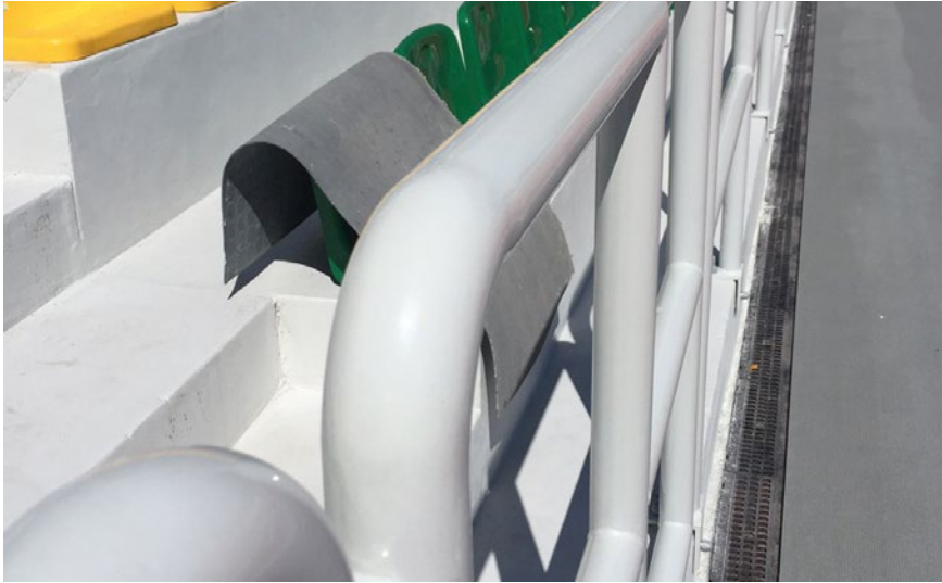
Wyjątkowa elastyczność powłok termoplastycznych sprawdza się m.in. na metalowych konstrukcjach ogrodzeń.
