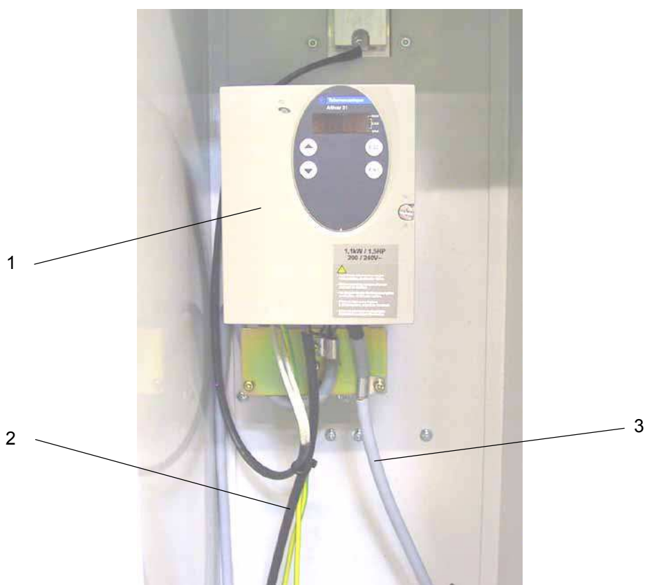
Manipulator ZA04 – Przeźmiennik częstotliwości
