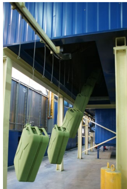
Piec ustawiony jest nad powierzchnią podłogi, co sprzyja oszczędnościom w ogrzewaniu.
