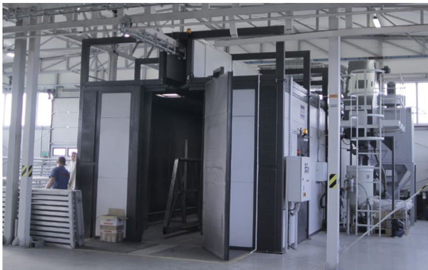
Śrutowania ręczna do obróbki elementów przed malowaniem.
